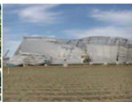
ハウスの倒壊 出典：農水省HPより
