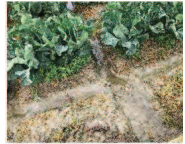
排水状況の確認・補修
